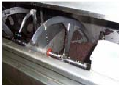
Σχήμα 1.2 : Εσωτερική διάταξη μαλακτήρων.
