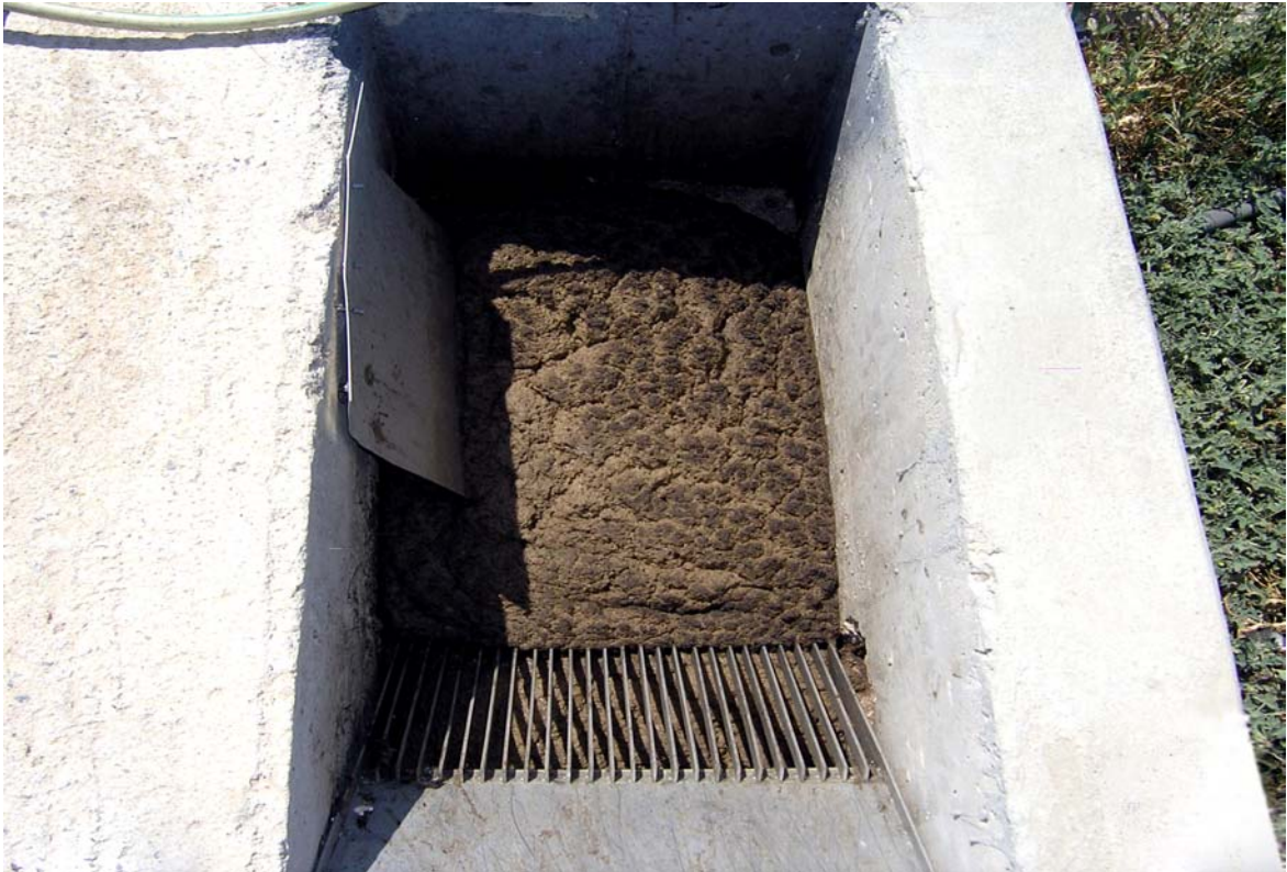
Εικόνα 3. Χειροκαθαριζόμενη σχάρα.
