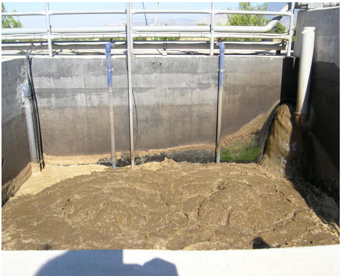
Εικόνα 4. Κεντρική δεξαμενή αερισμού.
