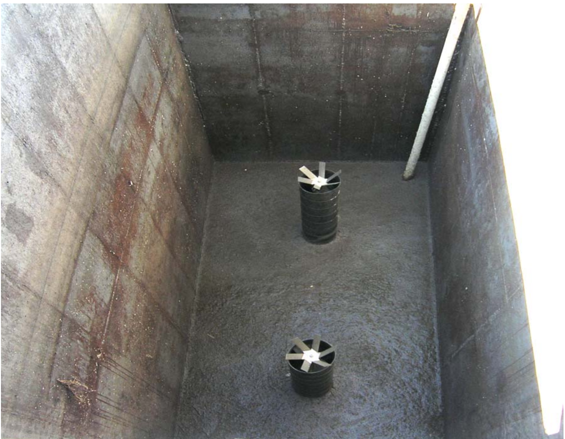
Εικόνα 6. Σύστημα αερισμού (στατικοί διάχυτες PULSAR ).
