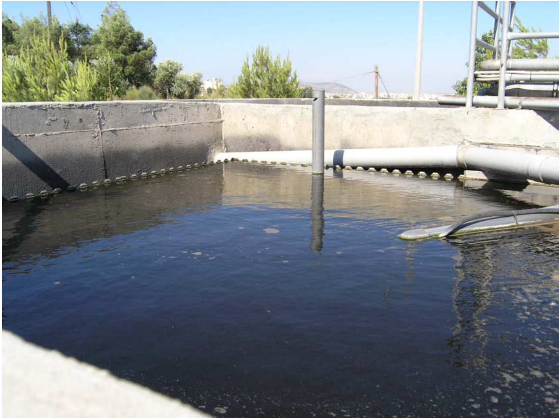
Εικόνα 5. Δεξαμενή τελικής καθίζησης.
