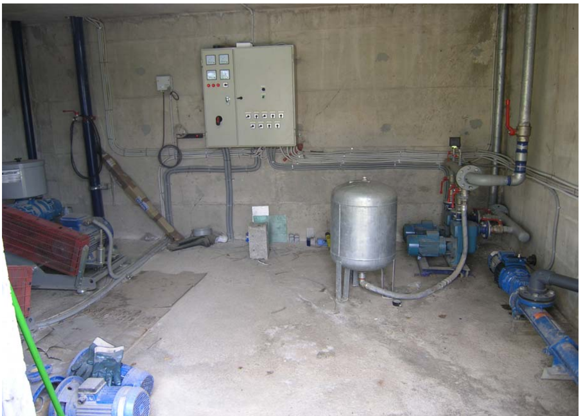
Εικόνα 2. Αντλιοστάσιο ανύψωσης λυμάτων.
