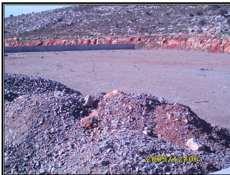
ΕΙΚΟΝΑ 5-7 Κλίνη τεχνητού υγροβιότοπου FWS Δήμου Καστελλίου Νομού Ηρακλείου, σε υπό κατασκευή στάδιο
