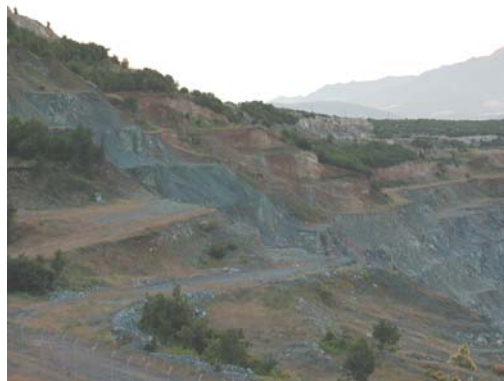
Σχήμα 6.8: Κατολίσθηση υλικού στο μεταλλείο
