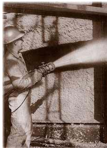
Σχήμα 2.11: Σχήμα 2.11 Μέθοδος ψεκασμού υλικού που περιέχει αμίαντο
