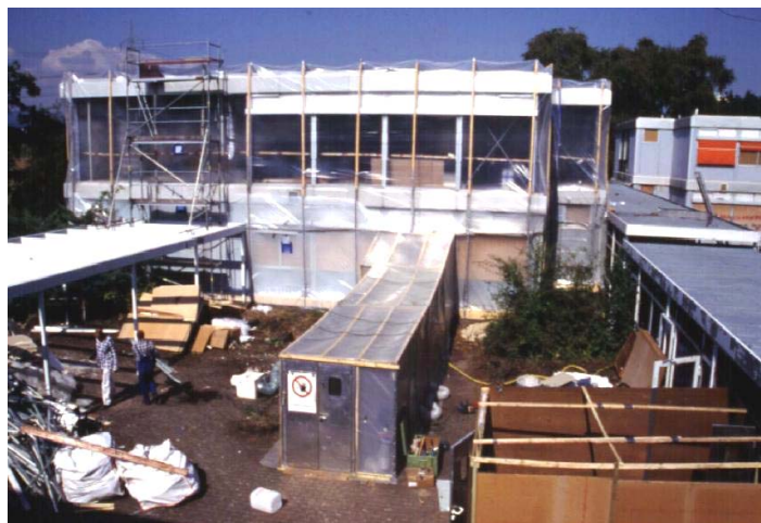
Σχήμα Π.1: Επικάλυψη του σχολικού συγκροτήματος με ειδική μεμβράνη (Περίφραξη)
