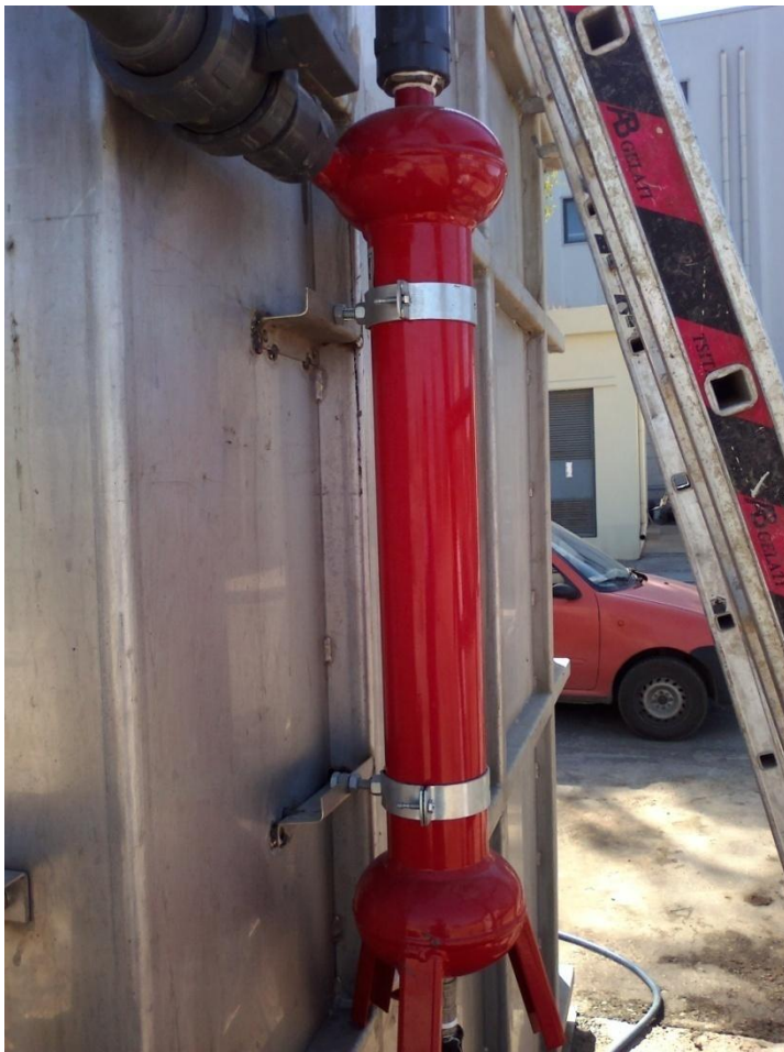
Εικόνα Α. 7: Κυκλώνας στο ρεύμα τροφοδοσίας του συστήματος MBR
