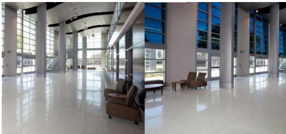
Εικόνα 1: Αντικατάσταση συμβατικών υαλοπινάκων (αριστερά) με ημιπερατά Φ/Β στοιχεία (δεξιά)
