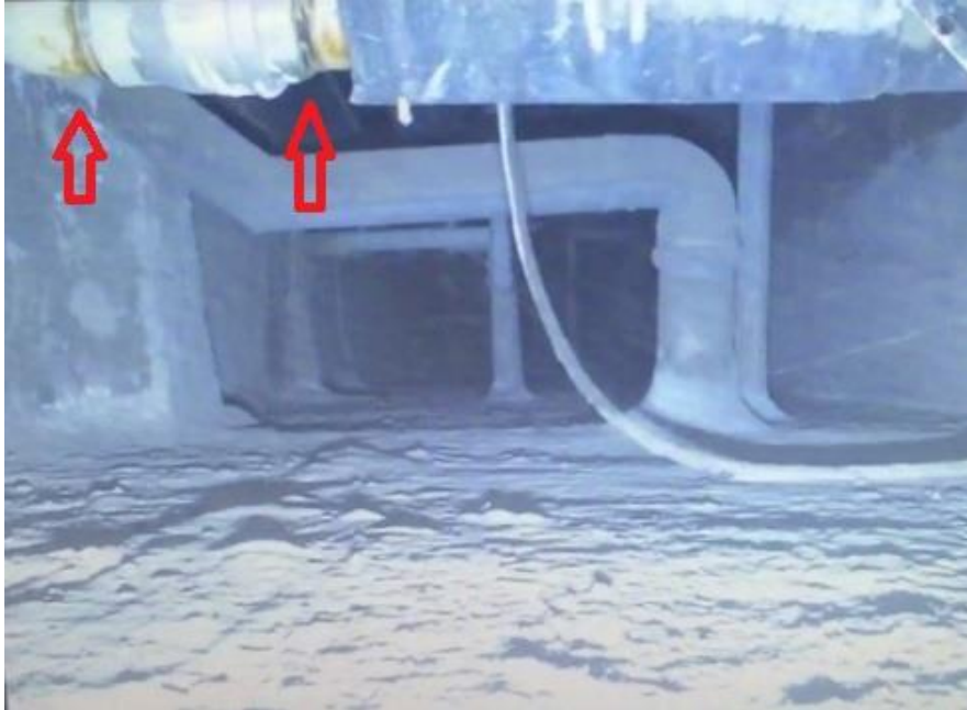
Σχήμα 9.1: Πρόβλημα διαρροής αγωγού που εντοπίστηκε κατά την διάρκεια επιθεώρησης του ρομποτικού οχήματος εντός μεταλλικής κατασκευής
