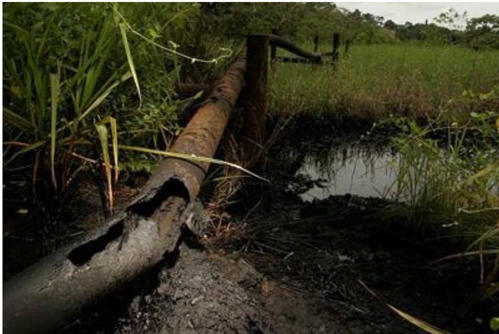
Σχήμα 2.17: Ολική καταστροφή αγωγού πετρελαίου με συνεπακόλουθες σοβαρές Περιβαλλοντικές επιπτώσεις
