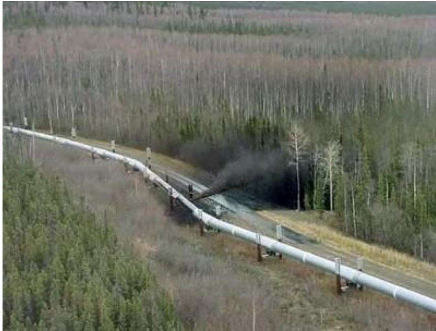
Σχήμα 2.19: Διαρροή πετρελαίου με συνεπακόλουθη Περιβαλλοντική καταστροφή εξαιτίας κακής συντηρήσεως του αγωγού συστήματος μεταφοράς, η οποία οδήγησε στην εκκένωση του χωριού Toccate στην περιοχή Ayacucho στο Περού. (2005, North Peruvian Oil Pipeline)
