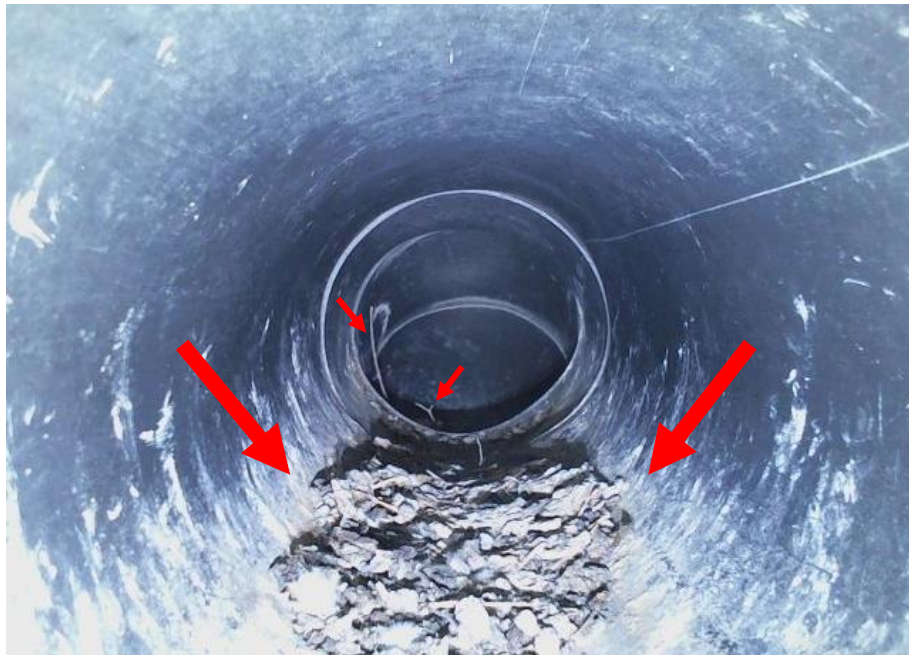
Σχήμα 9.2: Εσωτερικό τμήμα αγωγού με πρόβλημα συσσώρευσης υλικού και πιθανής φράξης
