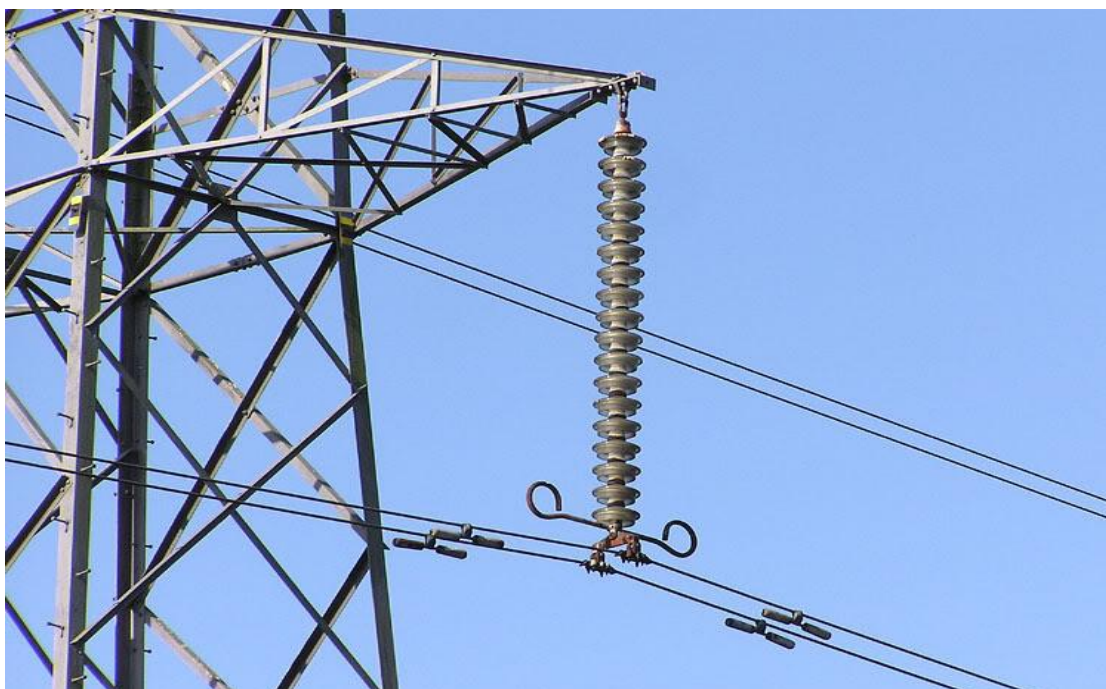
Εικόνα 1.5: Δυο αγωγοί ίδιας φάσης της τάξεως 400KV αναρτημένοι σε πυλώνα μέσω μονωτήρα.
