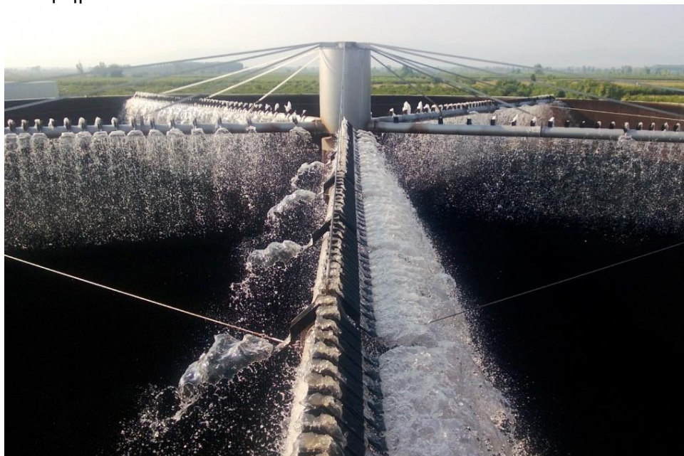
Εικόνα 4.3.2.1. : περιστρεφόμενος διανομέας λύματος (www.euromarket.com.gr, 2016)
