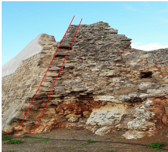
Εικόνα 4.4: Δομή τείχους σε σημείο κοντά στην περιοχή μελέτης. Πάχος περίπου 3.5 m. Μεταξύ των κόκκινων γραμμών απεικονίζεται το επιφανειακό στρώμα του τείχους. Μετρήθηκε περίπου 30 cm.
