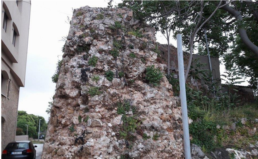
Εικόνα 4.5: Δομή τείχους σε σημείο στην ανατολική πλευρά των Χανίων. Πάχος περίπου 4 m
