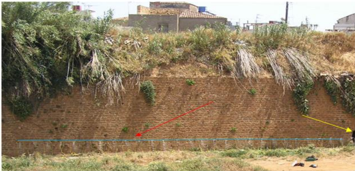
Εικόνα 4.1: Η εικόνα του τείχους τη χρονιά που έγιναν οι μετρήσεις (2006). Το κόκκινο βέλος δείχνει την οριζόντια γραμμή μελέτης, η οποία έχει μήκος 27 m και βρίσκεται σε ύψος 1.7 m από το έδαφος. Το κίτρινο βέλος δείχνει την τρύπα που υπήρχε, αλλά μπαζώθηκε, αριστερά από την οποία ξεκινάει η γραμμή μελέτης με κατεύθυνση Νότο προς Βορρά.
