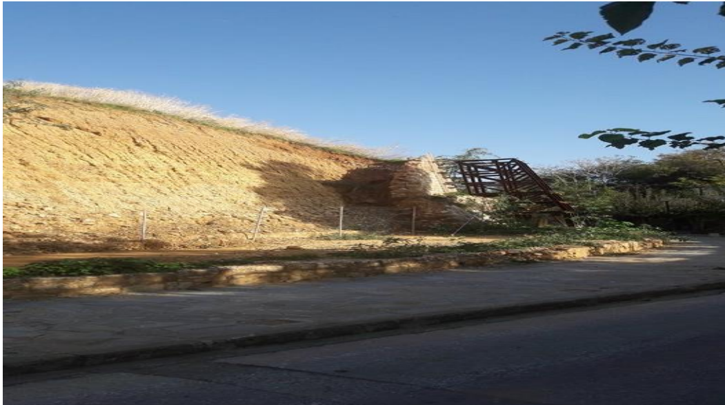
Εικόνα 4.7: Τείχος μπροστά από πρανές. Το κενό μεταξύ τους έχει πληρωθεί με επιχωματώσεις από την εκσκαφή του πρανούς. Στην εικόνα φαίνεται επίσης ότι το τείχος επισκευάζεται.
