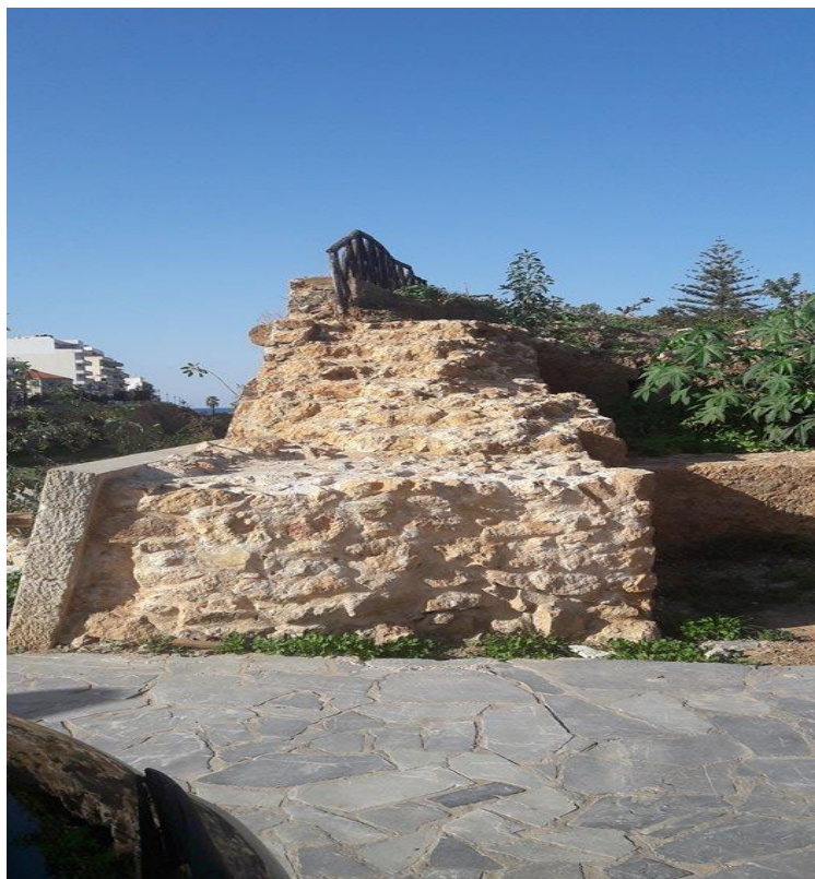
Εικόνα 4.6: Δομή του τείχους όπου έγινε η γεωφυσική έρευνα στη δυτική τάφρο. Βρίσκεται σε ύψωμα και δεξιά της γραμμής μελέτης. Πάχος περίπου 2.5 m
