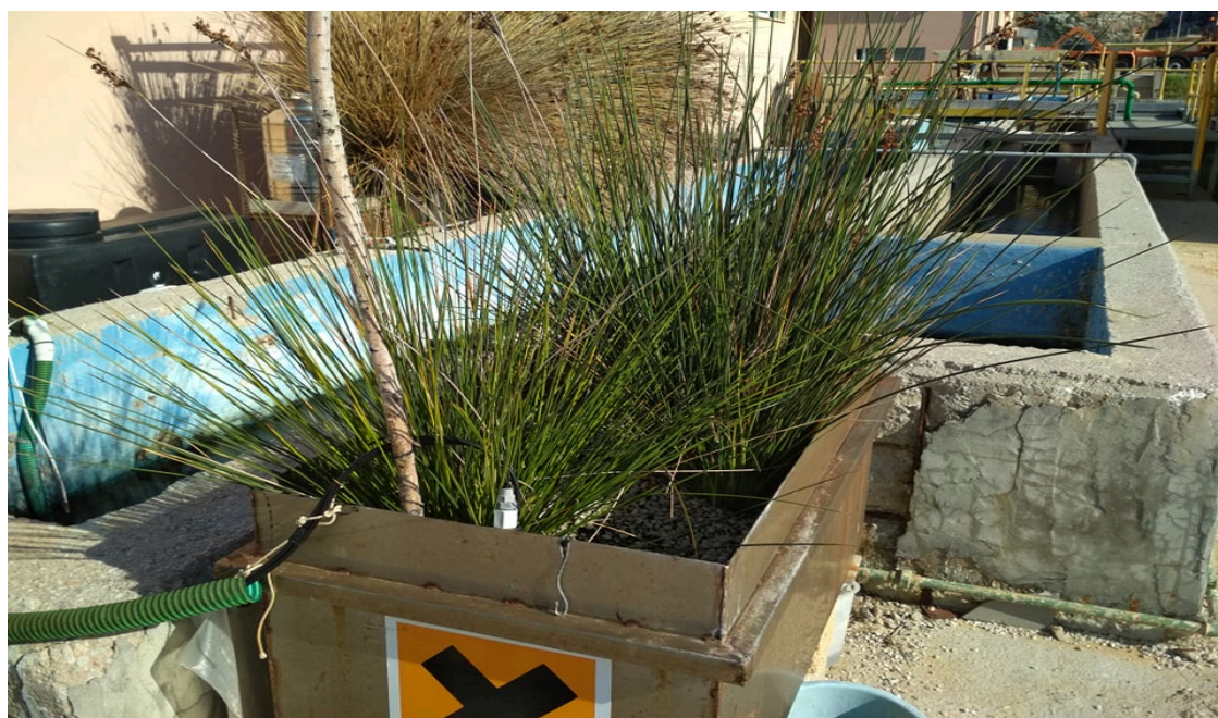
Εικόνα 3.3: Ο τεχνητός υδροβιότοπος εγκατεστημένος δίπλα στην εκροή της ΔΔΚ
