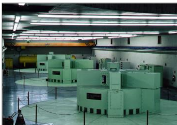
Εικόνα 16: Οι αναστρέψιμες μονάδες στο ΥΗΣ Σφηκιάς στον Αλιάκμονα
