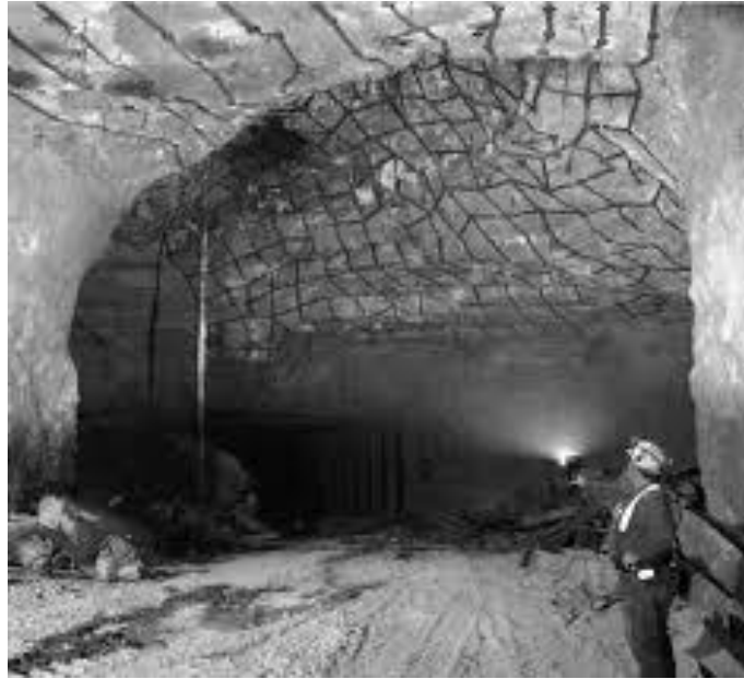
Σχήμα 17. Επισκευή μιας μεγάλης πτώσης στέγης στην οποία θεωρείται ότι η οριζόντια καταπόνηση έχει συμβάλει στην αποτυχία (Estenhuizen, Dolinar, Ellenberger, Prosser, & Iannacchione, 2011).
