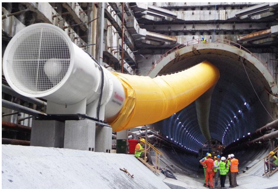
Σχήμα 7. Σύγχρονο σύστημα πρωτογενή εξαερισμού (TUR CERT, 2020)
