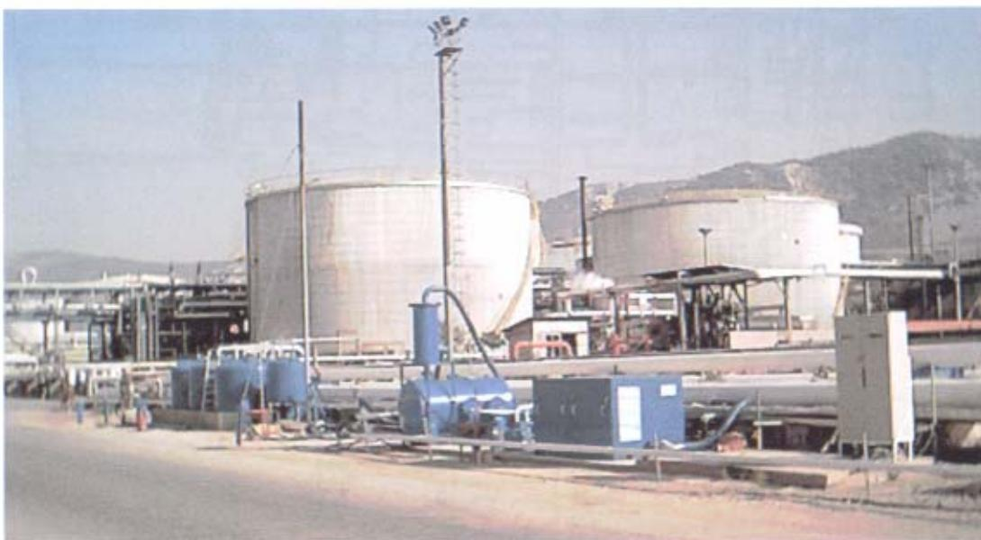
*Εικόνα 4-1: Όψη του συστήματος άντλησης (bioslurping) στις B.E.A.*
