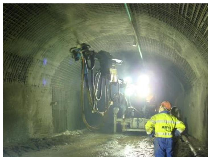
Σχήμα 2.12: Μηχανική εφαρμογή του εκτοξευόμενου σκυροδέματος (BASF, 2011)
