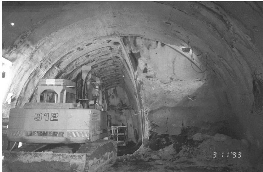
**Σχήμα 2.14:** Υποστήριξη σήραγγας με χαλύβδινα πλαίσια (BASF, 2011)
