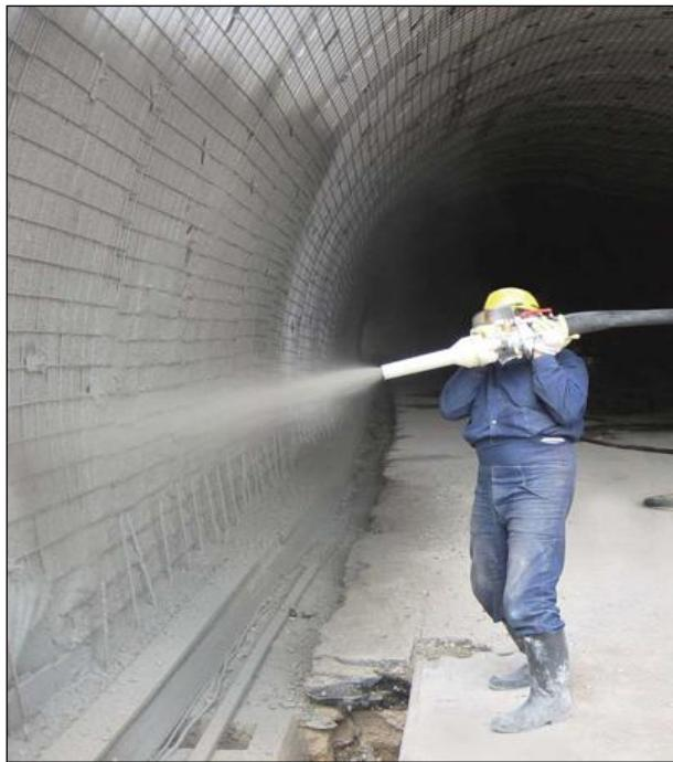
**Σχήμα 2.13:** Εφαρμογή εκτοξευόμενου σκυροδέματος σε σήραγγα σε συνδυασμό με πλέγμα (BASF, 2011)
