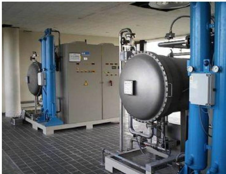
**Εικόνα 20. Τυπική διάταξη παραγωγής όζοντος (οζονιστήρας)**
